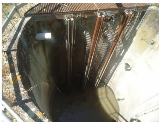
Figure 2 : Poste de relevage en entrée de la station de traitement des eaux usées communale actuelle de Saint-Andiol (SDA, 2016)
