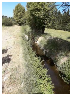
Roubine 270 m (rejet station)
