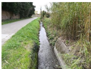
Roubine 440 m (rejet déversoir d’orage)
