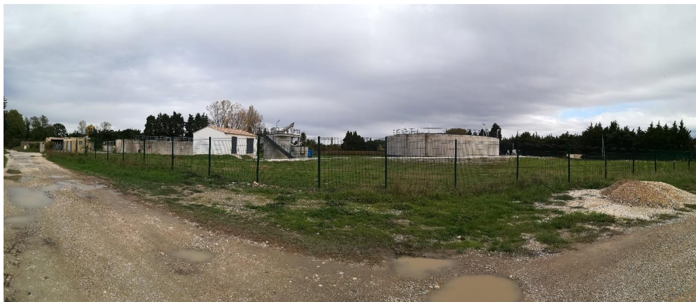
Figure 28 : Abords de la station de traitement des eaux usées communale actuelle de Cabannes et de la future station de traitement des eaux usées intercommunale (Cereg, Octobre 2018)
