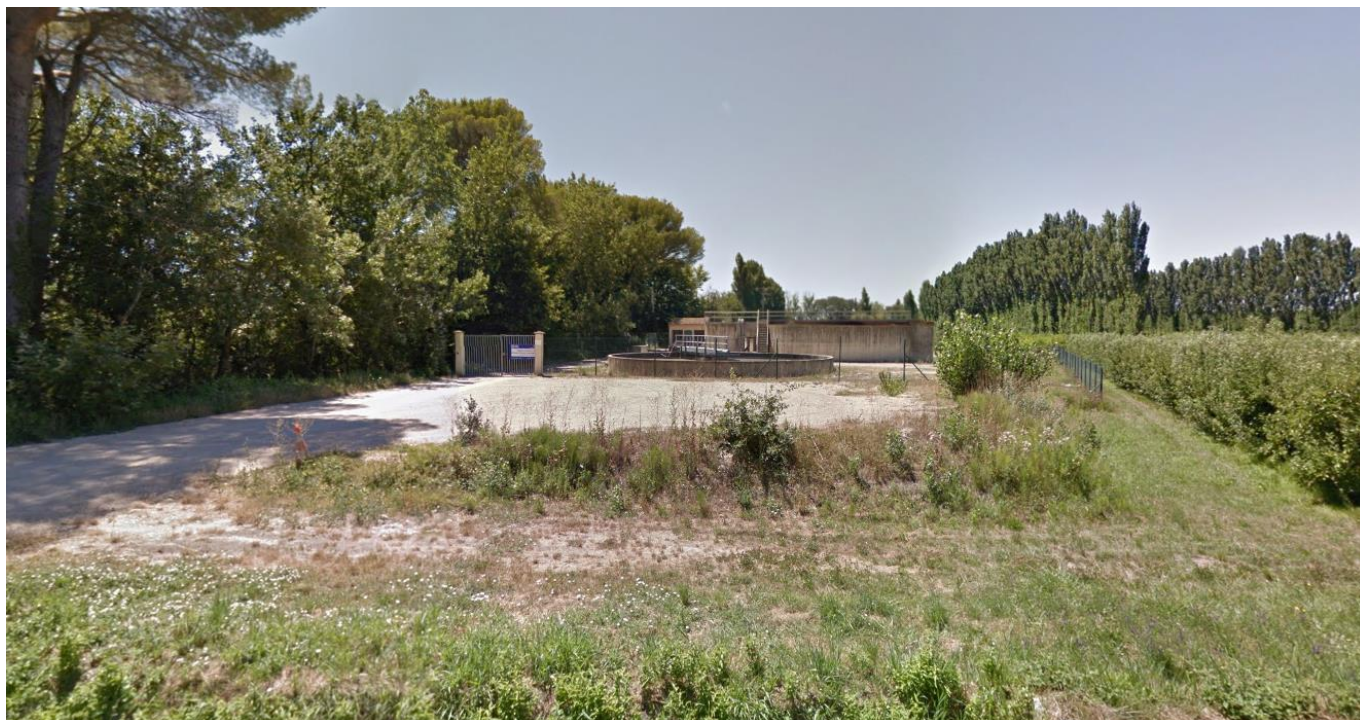
Abords de la station d'épuration communale actuelle de Saint-Andiol – Vue rapprochée (Cereg, Octobre 2018)
