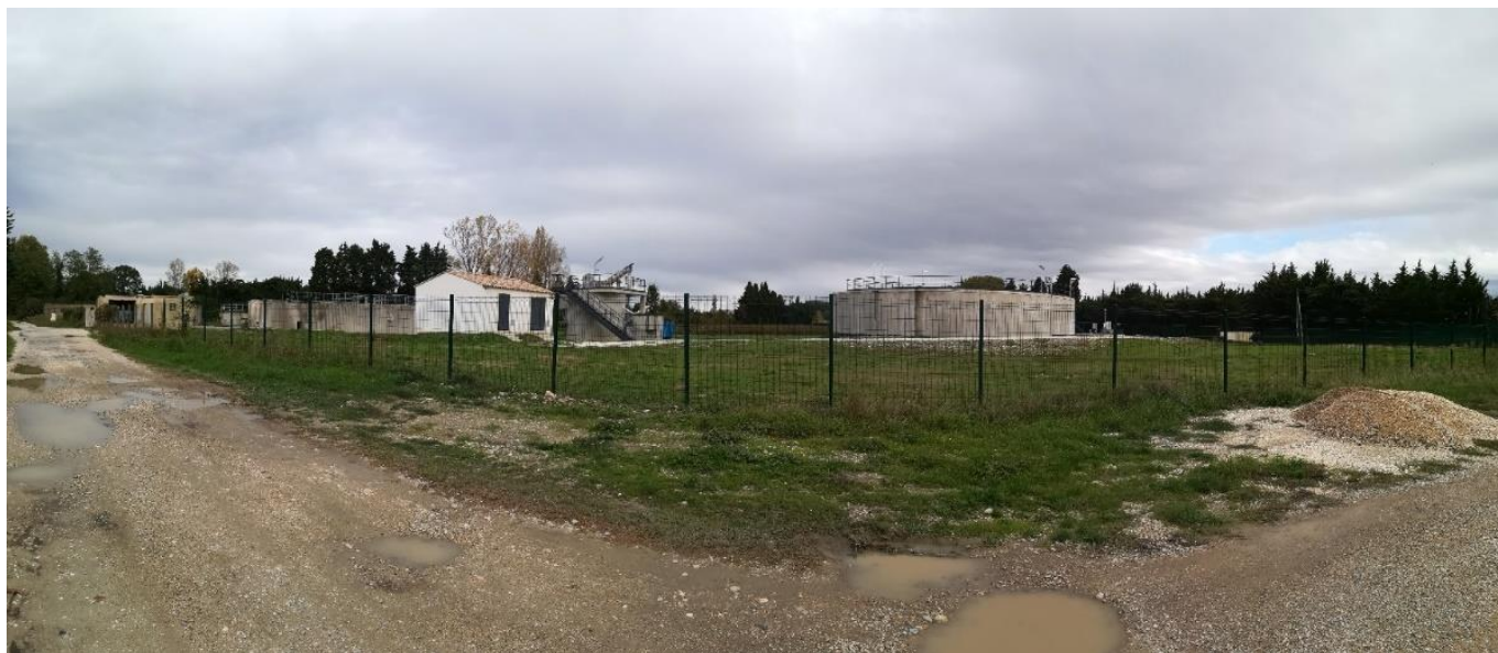
Abords de la station d'épuration communale actuelle de Cabannes et de la future station d'épuration intercommunale – Vue rapprochée (Cereg, Octobre 2018)
