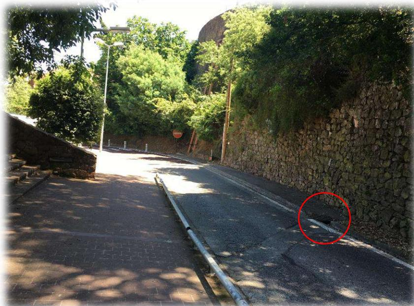
*Photo n°04 – Grille EP se rejetant dans l'ouvrage route*
