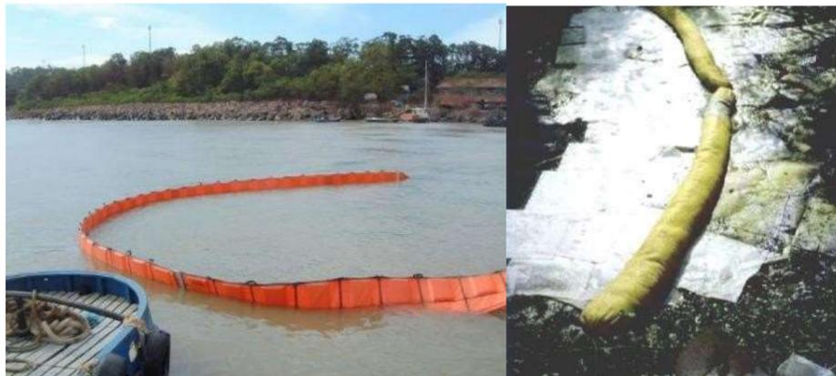
Figure 11 : Installation d'un barrage flottant / Barrage absorbant
