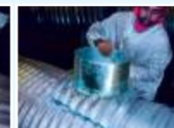
et à l'angle souhaité. Après avoir fait un trou à la disqueuse ou à la scie cloche, il suffit simplement de coller le piquage
