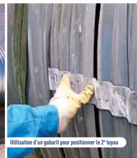
Utilisation d'un gabarit pour positionner le 2<sup>e</sup> tuyau
