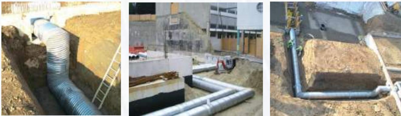
Les tuyaux SPIREL® offrent une alternative économique à la réalisation de **gaines de ventilation** ou de **désenfumage** par rapport aux solutions traditionnelles (carneaux béton, ...). Les pièces **fabriquées sur mesure** s'adaptent à tous types de configuration technique. Acier Galvanisé à chaud de qualité M0 (classe A1 selon la EN 13501-1) **incombustible**.
