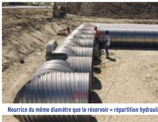
Nourrice du même diamètre que le réservoir = répartition hydraulique parfaite
