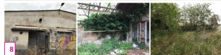
Intérieur des parcelles en friches sur Lyon 04 et Lyon 05 (photo BET Oasiis)
