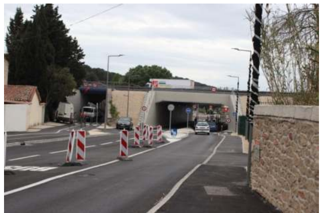
Passage du Zénibus sous la voie ferrée. Le pont a déjà été modifié et permet le passage en site propre.
