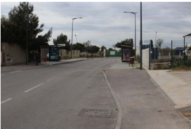
La station Athènes Rome vue en direction ouest. Cette station va être déplacée Boulevard de l'Europe.
