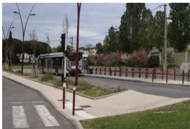
Le Square De Gaulle vu en direction est. Un parking et une zone de retournement seront créés pour l'extension du Zénibus.
