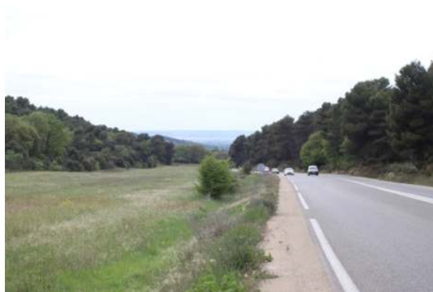
Avenue du Plan de Campagne (D6) vue en direction ouest à l'entrée de la zone commerciale. Cette avenue sera élargie pour accueillir une voie propre pour le Zénibus
