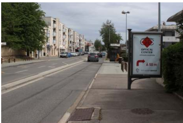
La station Padovani sur l'avenue Denis Padovani. Les deux arrêts de cette station seront rallongés. Photo en direction sud-est.
