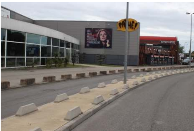
Le tracé du Zénibus devant le cinéma Le Pathé. Une station sera créée à proximité.
