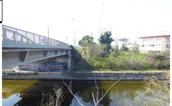
Canal de Marseille au Rhône
