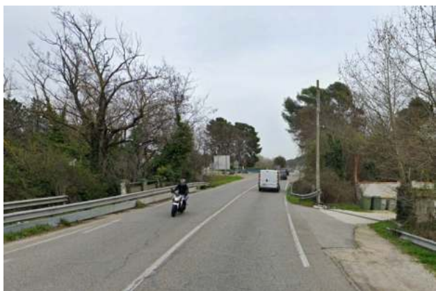
La D6 vue en direction est. Cette route sera élargie pour créer une voie propre pour le Zénibus.
