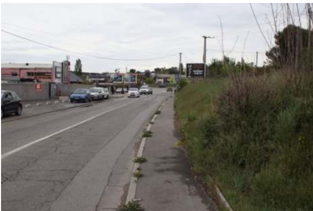
La route de Calas (D543) vue en direction nord. Cette route sera élargie à droite sur la photo pour la création d'une voie propre au Zénibus.
