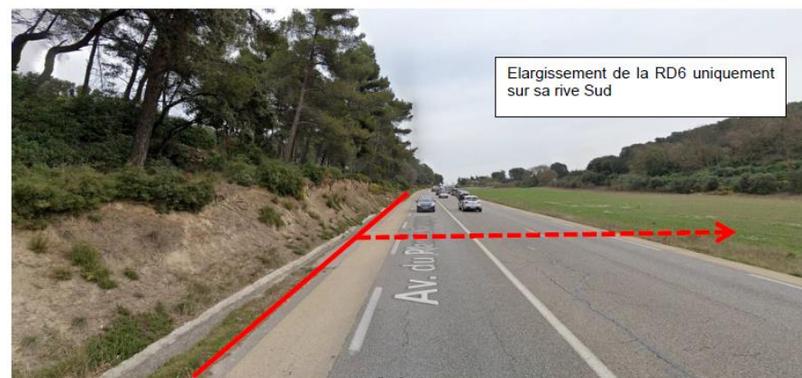
RD6 – principe retenu pour l'élargissement
