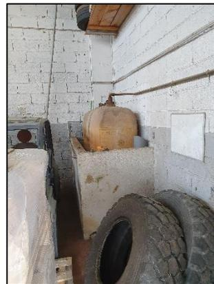
Figure 9. Vue sur la cuve à fioul sur bac de rétention en béton
