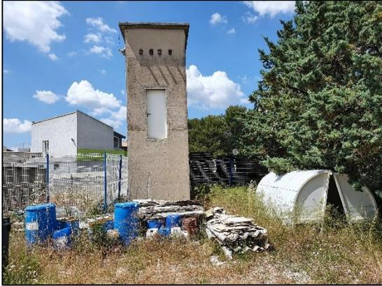
Figure 4. Vue de l'ancien transformateur EDF et des bidons non placés sur rétention
