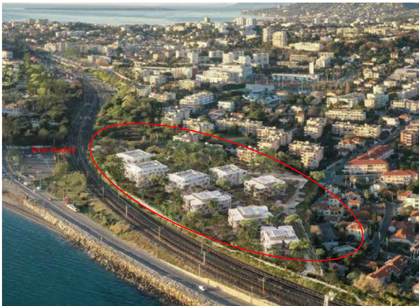
Figure 5. Insertion du projet dans son environnement
