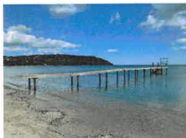
Vue depuis le sud
