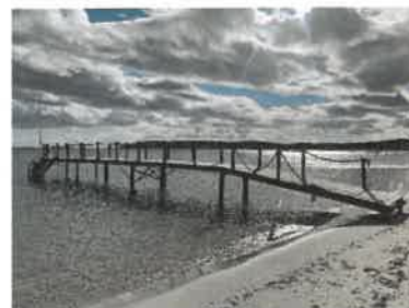
Vue depuis le Nord
