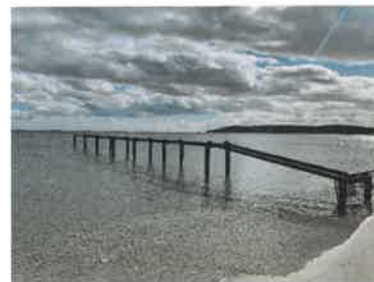
Vue depuis le Nord
