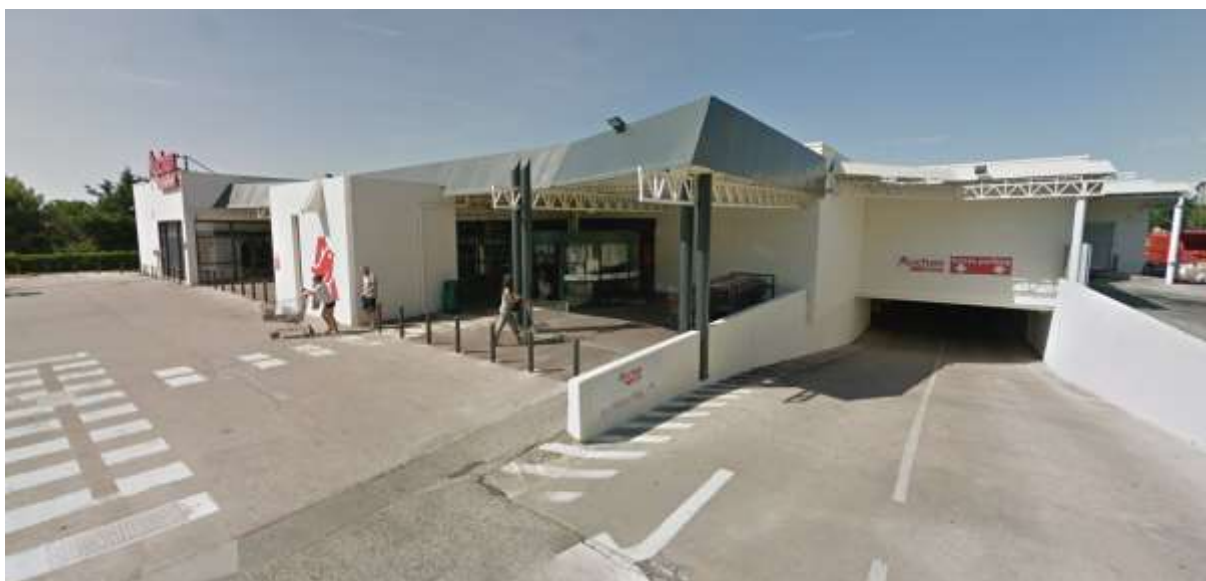
Vue 1 – Magasin existant avec son parking en sous-sol
