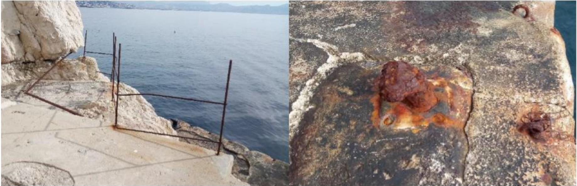
Garde-corps et bollards corrodés sur le quai Sud
