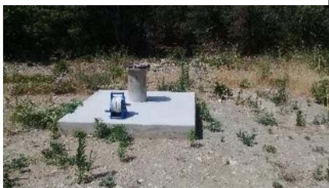
Forage d'exploitation F2
