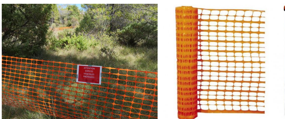
Balisage de chantier à mettre en place
