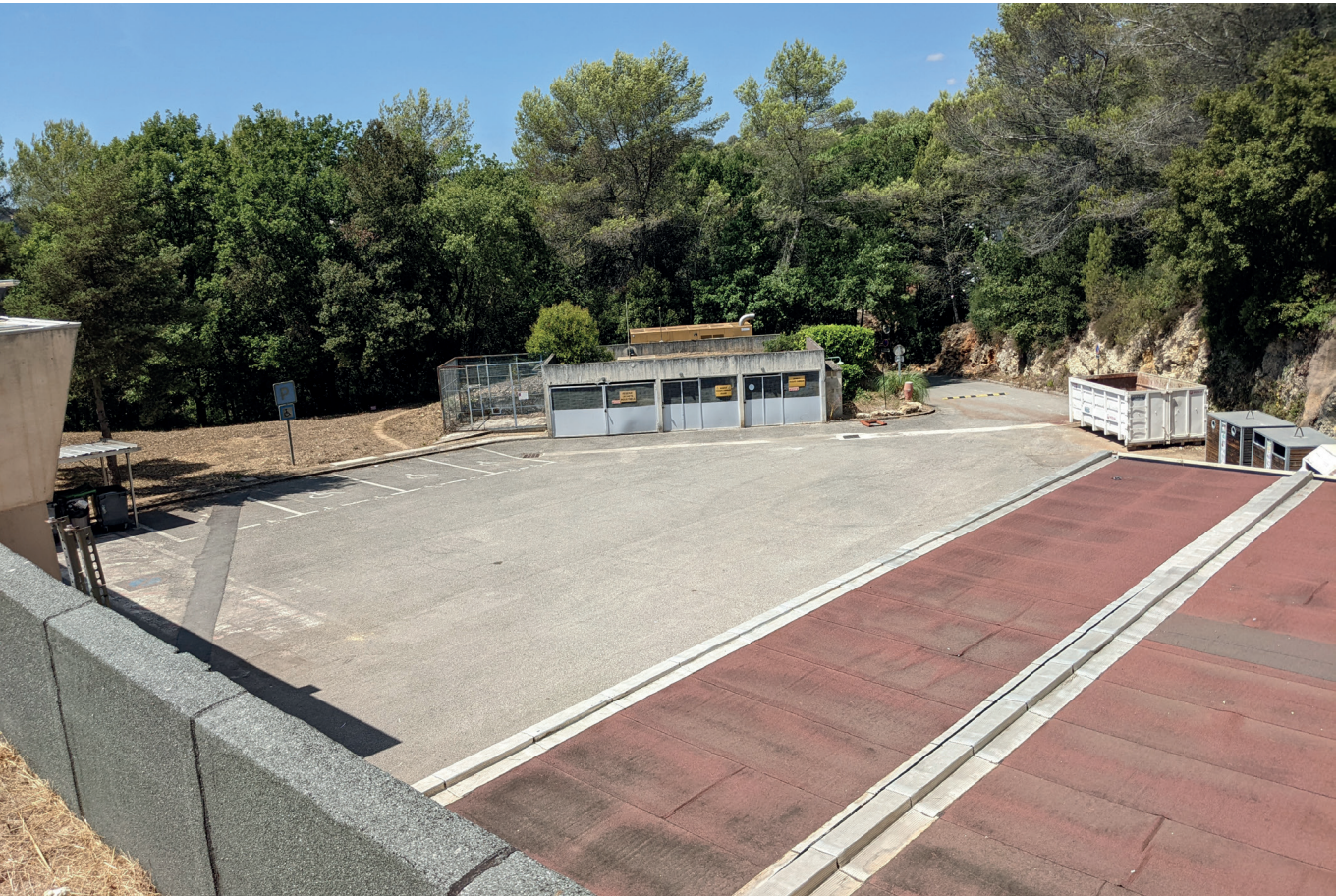
V6. Photographie de l'existant. Vue sur la zone de livraisons et services.
