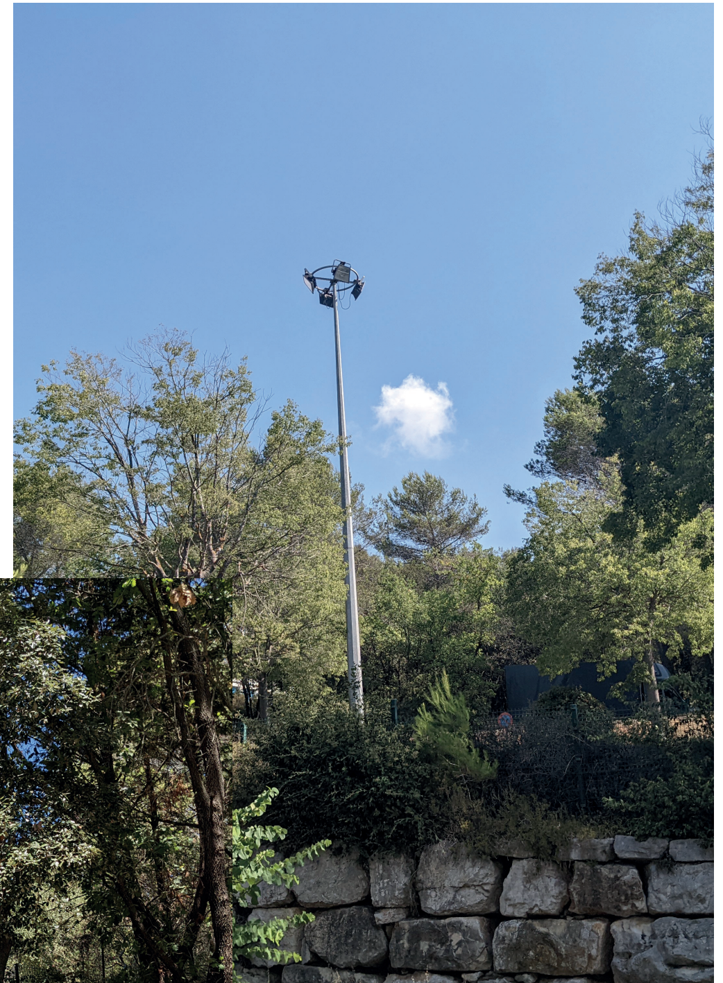
Photographie de l'existant. Mât d'éclairage.
