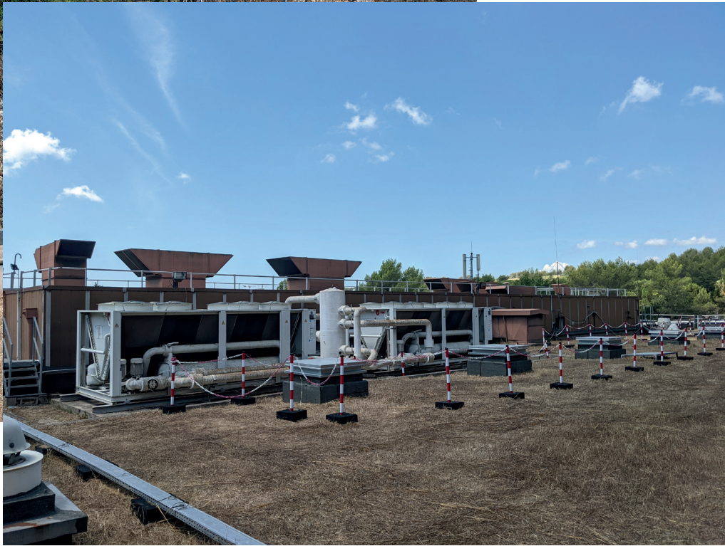
V11. Photographie de l'existant. Toiture.
