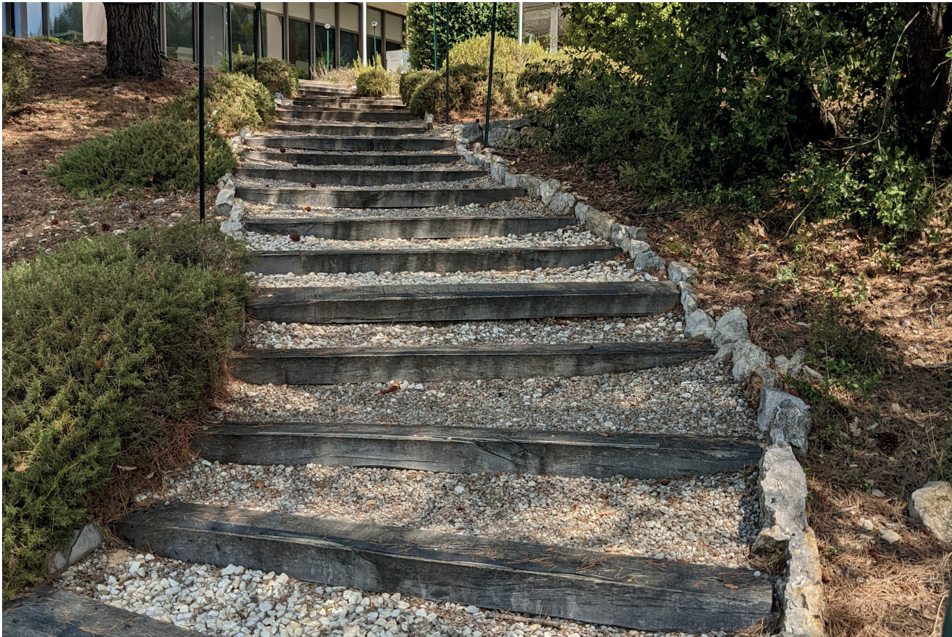
V7. Photographie de l'existant. Escaliers en traverses de chemin de fer.
