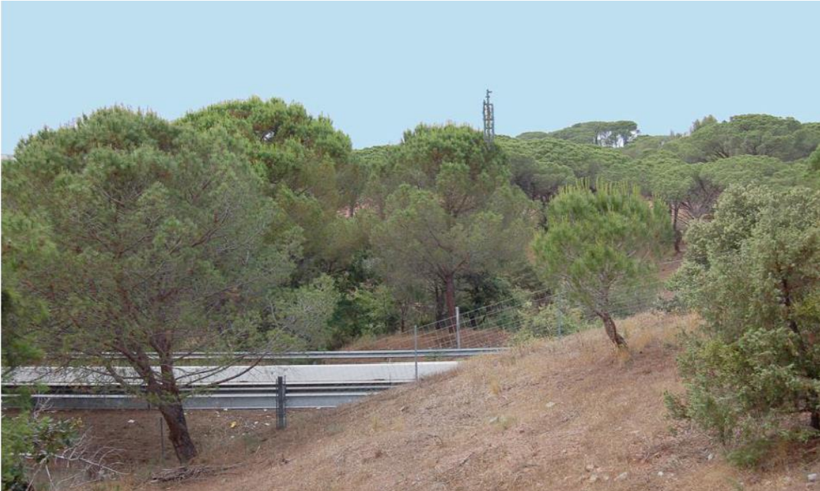
Vue au cœur de la pinède des Valettes supportant le dispositif des aménagements autoroutiers
