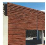
Revêtement de Façade en béton architectonique obtenu avec des matrices de coffrage
