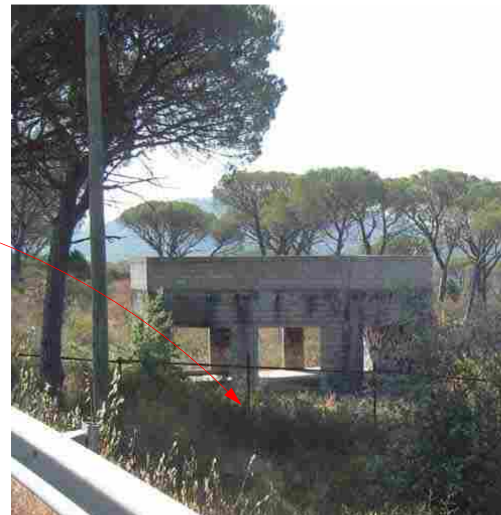
Construction existante : Murs périphériques existants vestiges d'un démarrage interrompu de mise en œuvre d'un ancien PC
