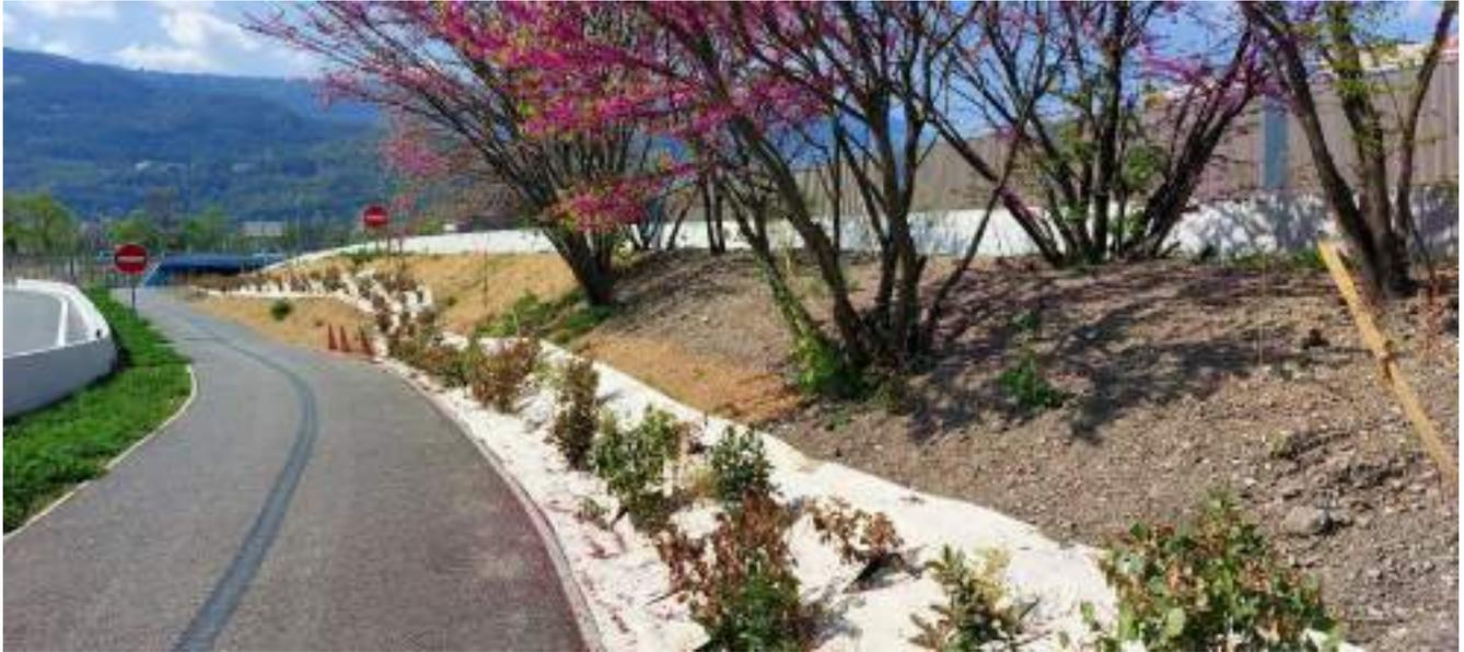
*Treillis coco et géotextile sur talus pour fixation de la végétation – Grenoble bretelle d'accès A480 – Photo SETIS*
