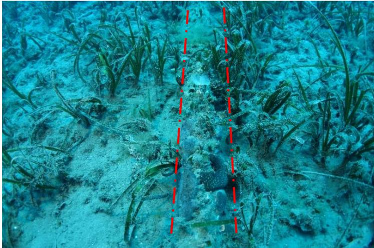
Figure 82 : Câble de transport d'énergie SACOI2 en limite inférieure de l'herbier entièrement colonisé (Bastia – plage de l'Arinella, 2020)
