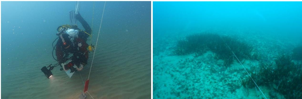
Figure 5 : Filin lesté sur le fond marquant le tracé du câble sous-marin
