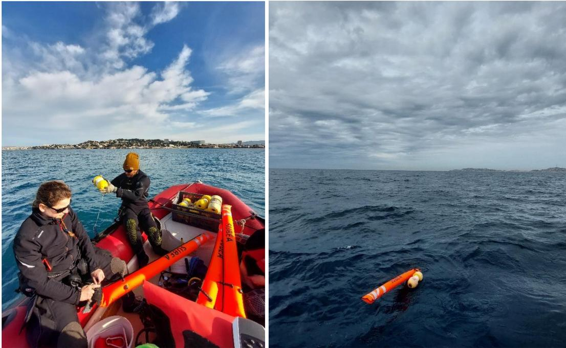
Figure 4 : Installation des balises le long du tracé du câble
