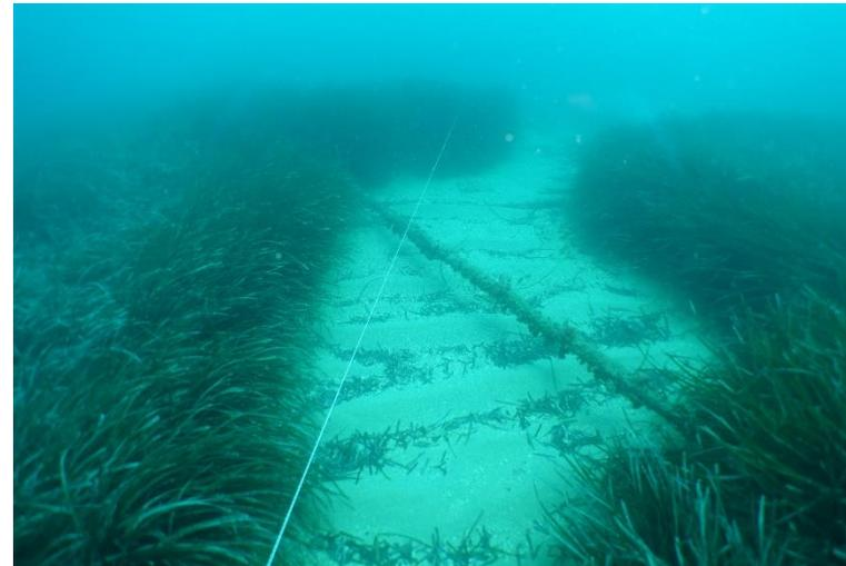
*Figure 89 : Câble télécom en suspension au passage d'une zone d'intermatte (Marseille, 2020)*
