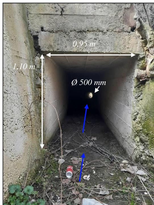
Photographie 9 : Deuxième cadre béton en sortie de l'ouvrage béton à ciel ouvert et buse Ø 500 mm
