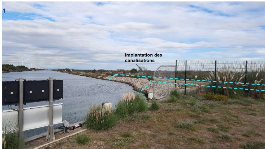
Implantation de la prise d'eau, de la prise de rejet et des canalisations en aval de l'écluse de Barcarin (canal de Barcarin à Fos)
