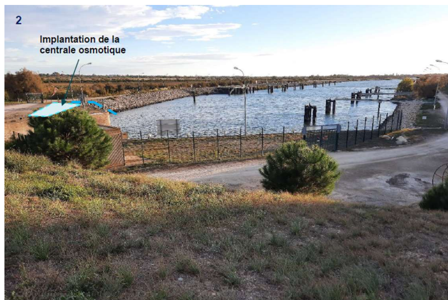
Implantation des conteneurs de la centrale osmotique et de la prise d'eau douce en amont de l'écluse de Barcarin, à l'intérieur du périmètre clôturé de l'écluse
