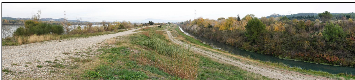
Figure 20 : Le Rhône et le contre-canal rive gauche au pont d'Aramon
