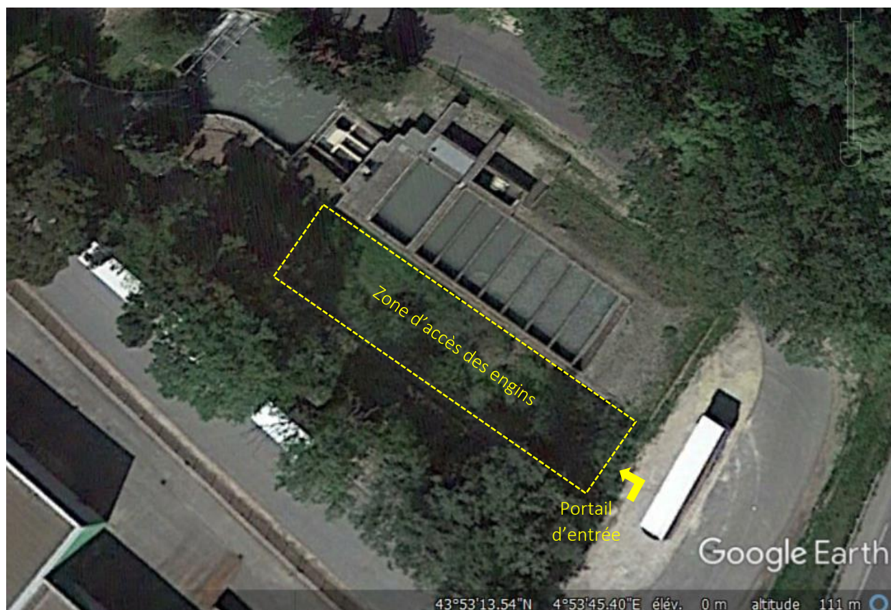
Figure 2 : Vue du bassin de décantation au partiteur de Noves
