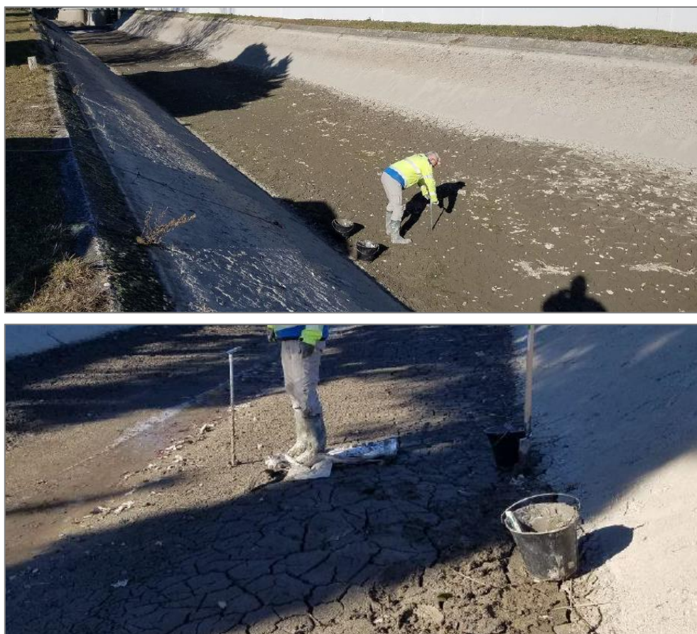
Photo 3 a et b : Vue des matériaux devant faire l'objet du curage au sein du canal de Bonpas (période de chômage hiver 2021/2022)
