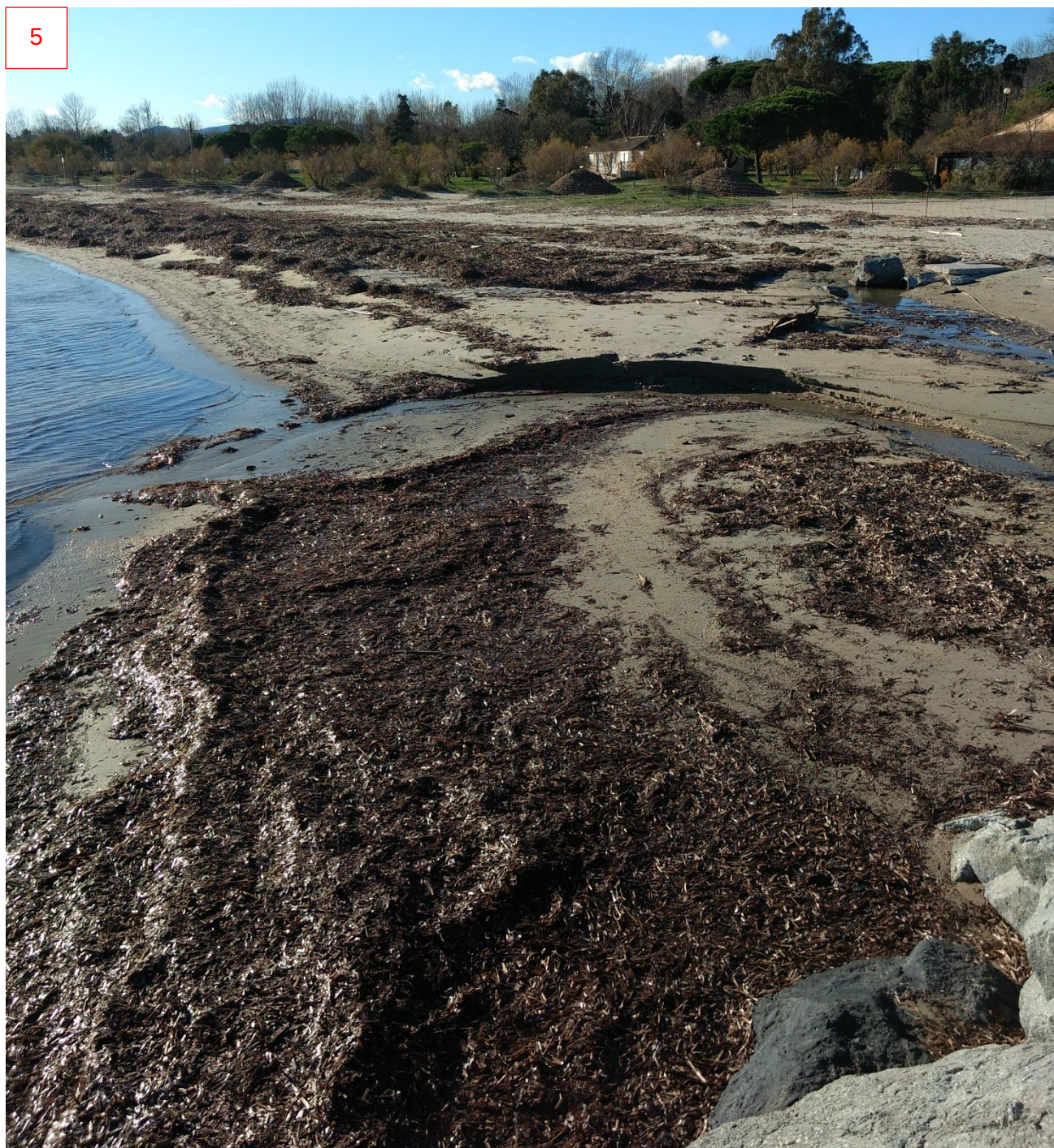
Figure 8 - Photo de la partie est de la zone de projet (depuis l'épi) - Novembre 2019
