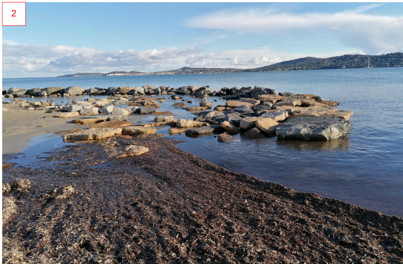
Figure 5 - Photo de l'extrémité ouest de la digue - Janvier 2021
