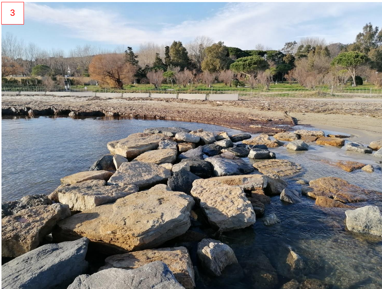
Figure 6 - Photo de l'extrémité ouest de la digue - Janvier 2021
