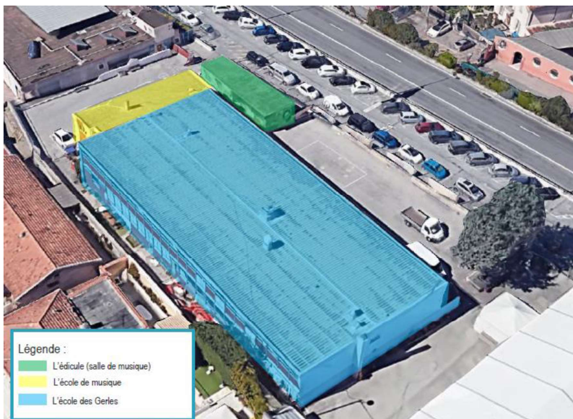
Localisation des bâtiments à démolir
