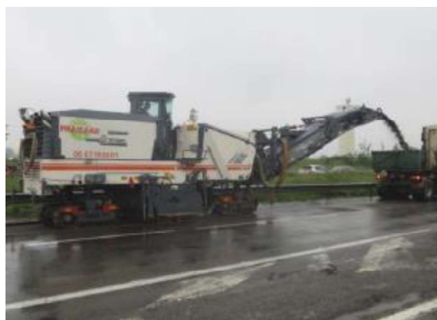
Fraisage et chargement direct sur camion
