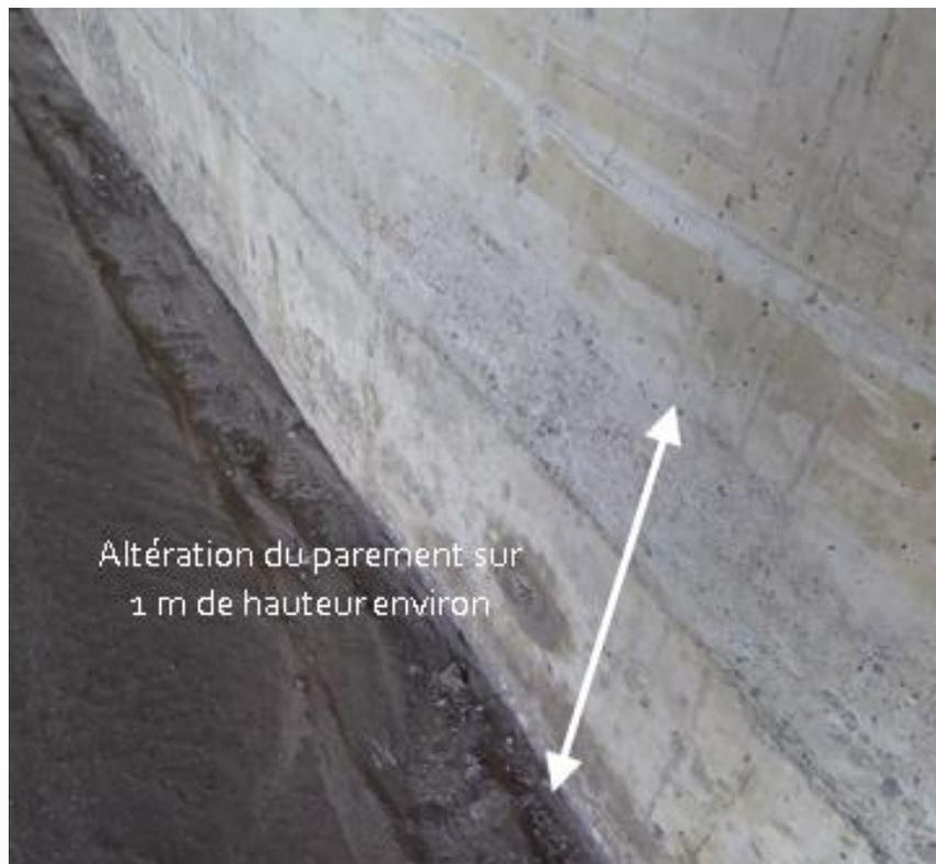
**Figure 18** : Altération parement
