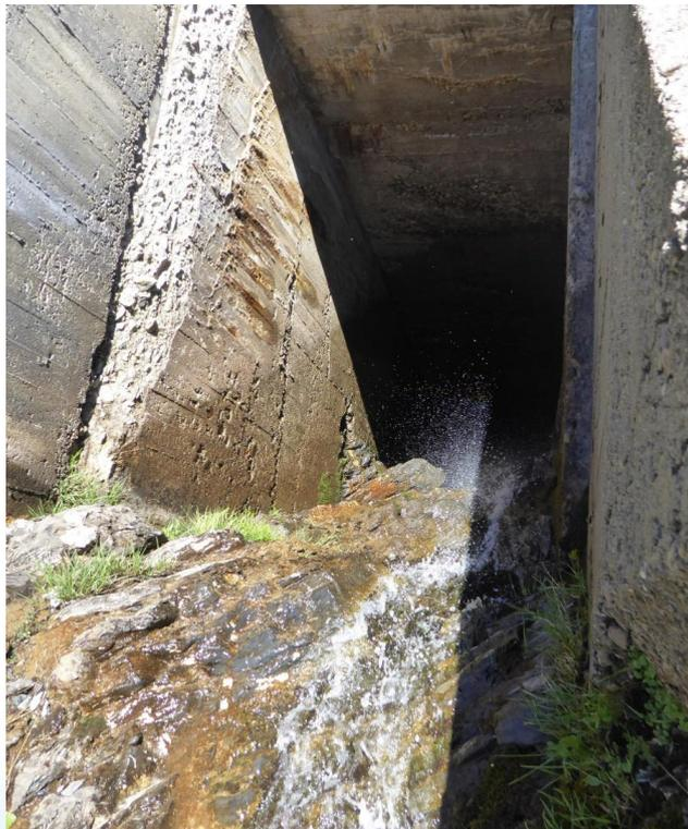
**Figure 17** : Ouvrage hydraulique travée 4 où l'eau est projetée contre l'amont du mur amont existant
