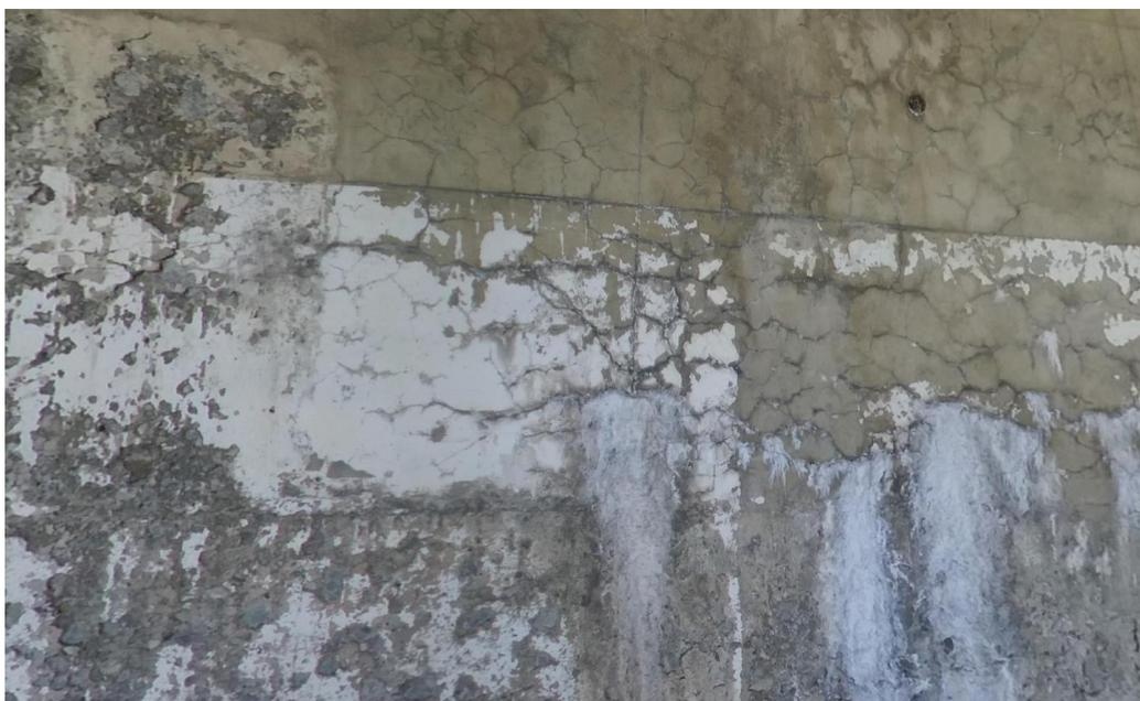
**Figure 20 : Fissuration superficielle**
