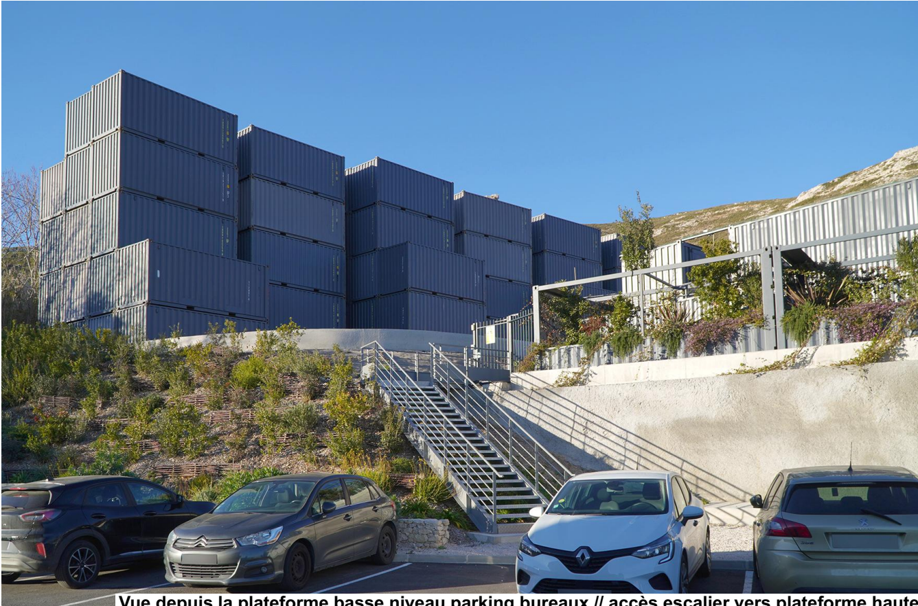
Vue depuis la plateforme basse niveau parking bureaux // accès escalier vers plateforme haute
