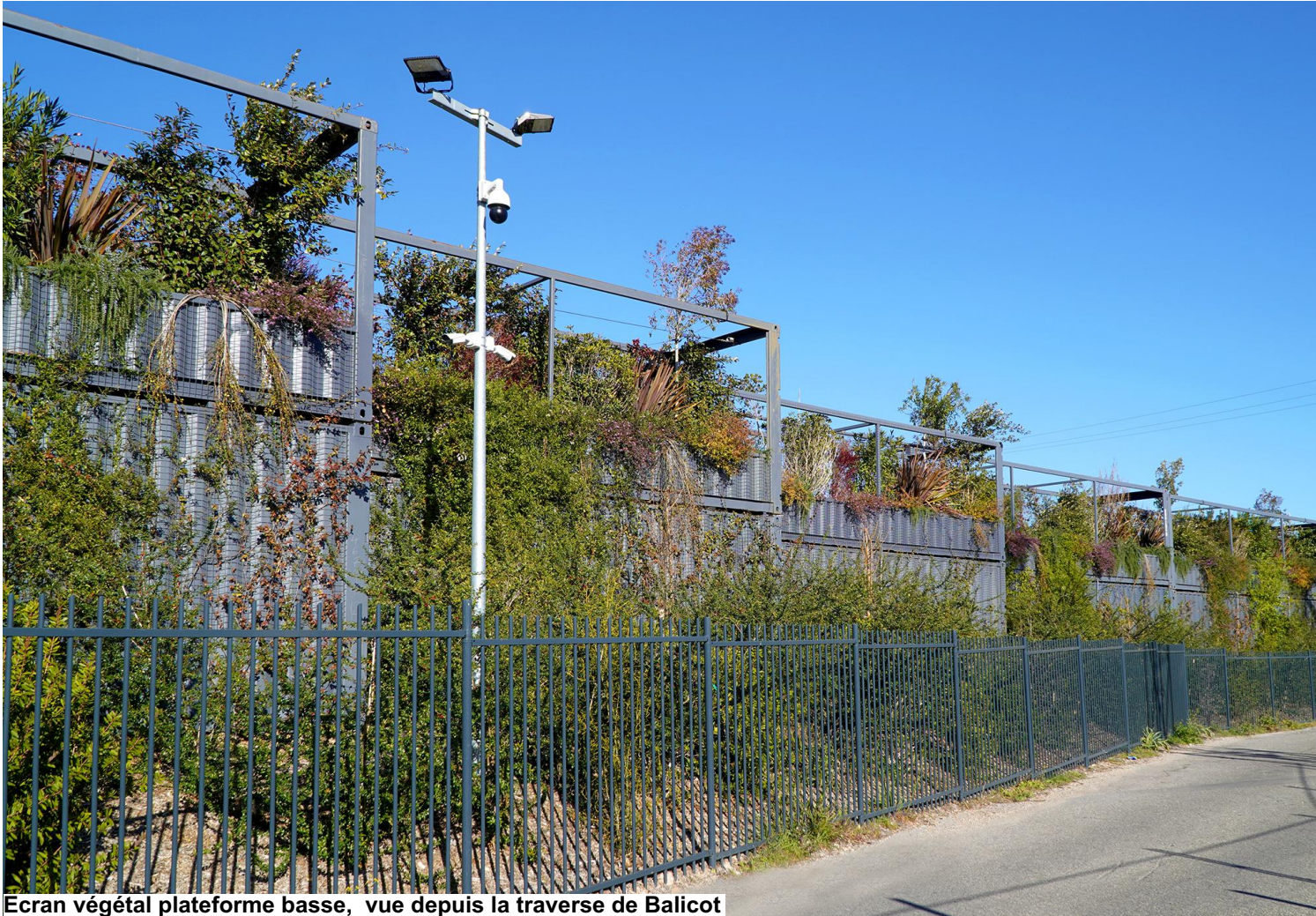
Ecran végétal plateforme basse, vue depuis la traverse de Balicot
