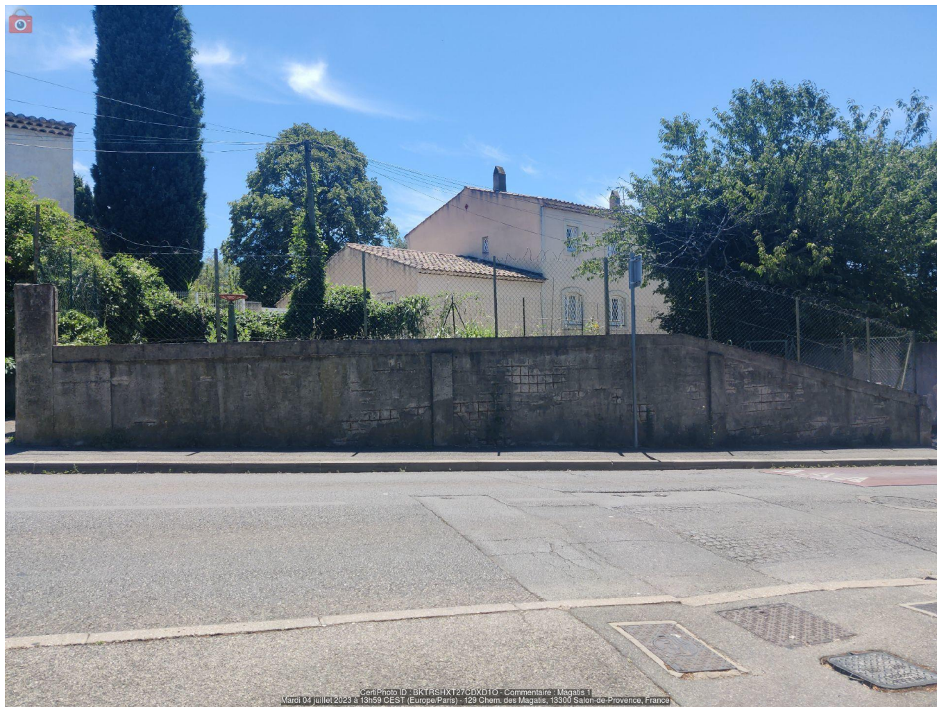
Photo certifiée 1 : Vue latérale ancienne chambre d'eau
