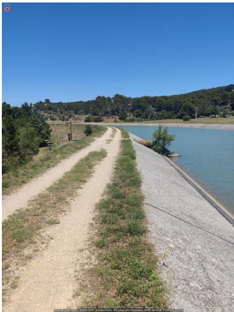
Photo 4 : Vue prise d'eau existante dans le canal EDF
