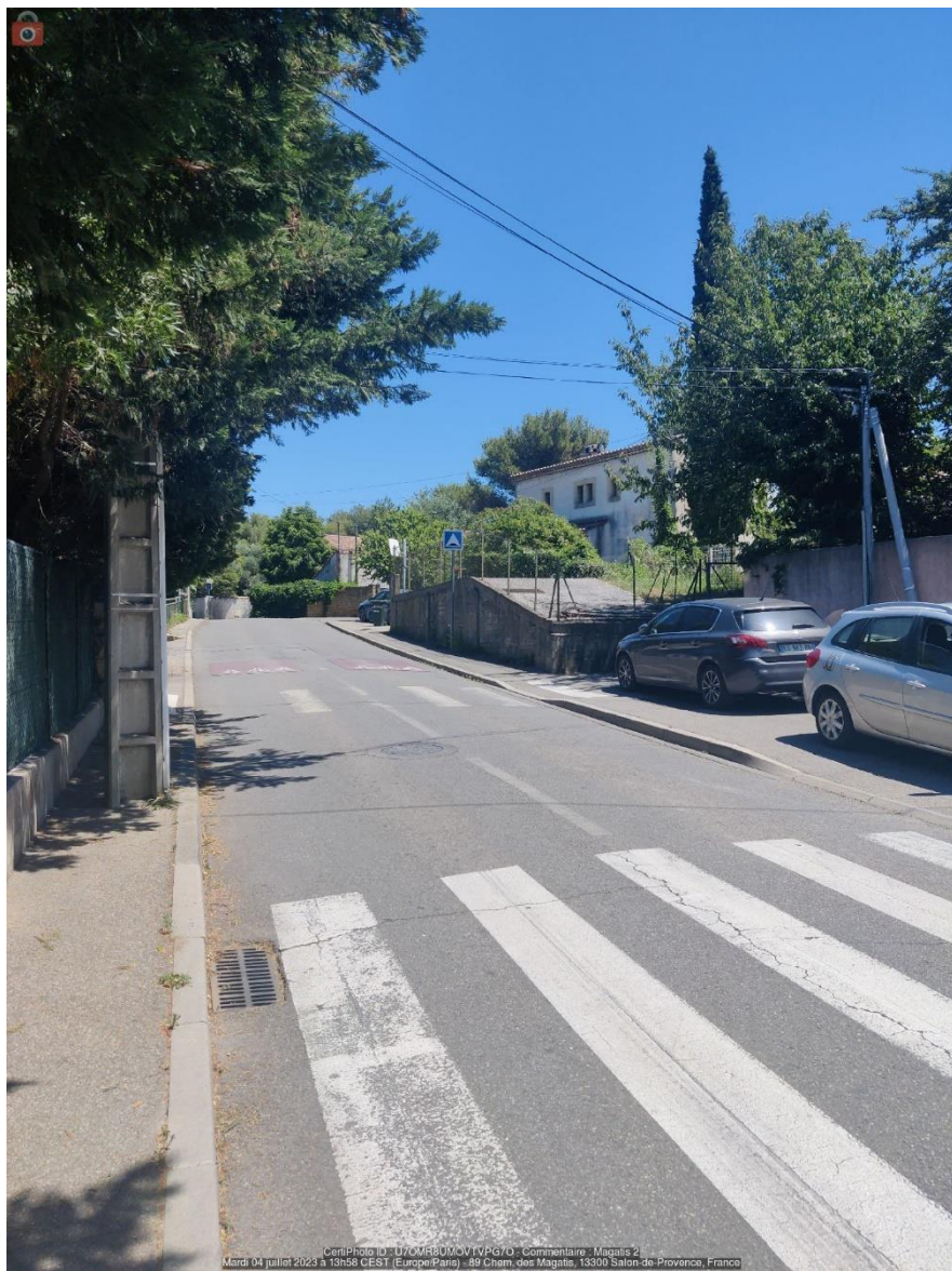
Photo 2 : Vue ancienne chambre d'eau vers l'amont
