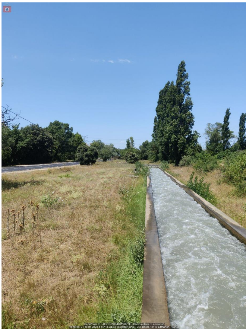
Photo 5 : Vue du coursier et de la berge vers l'aval à mi-parcours
