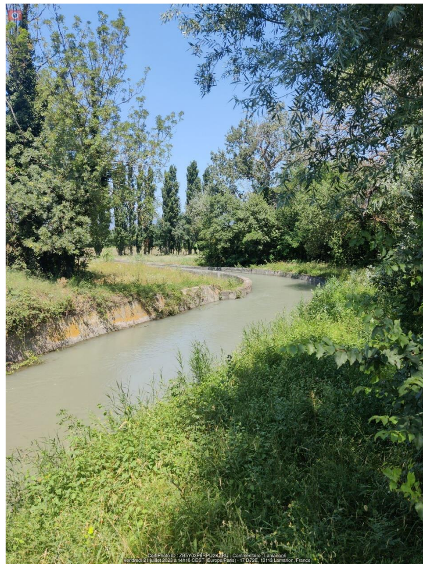
Photo 7 : Vue du départ du coursier vers l'aval
