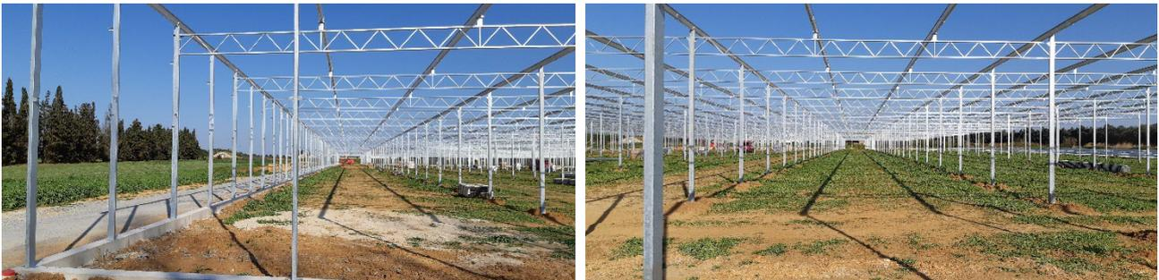
**Figure 16** - Montage structure d'une serre photovoltaïque. Source : Reden Solar.
