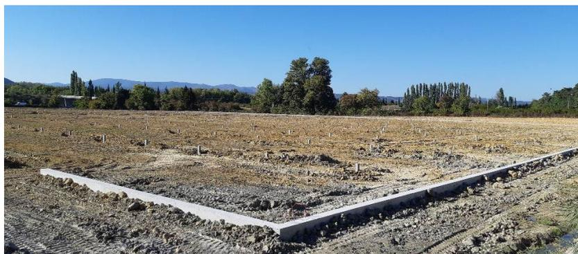
**Figure 16** - Fondations béton extérieures (longrine). Source : Reden Solar.
