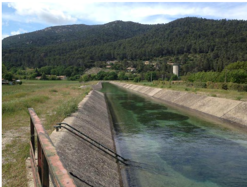
Illustration n°21: Photographie du canal aérien de la SCP au niveau de Signes
