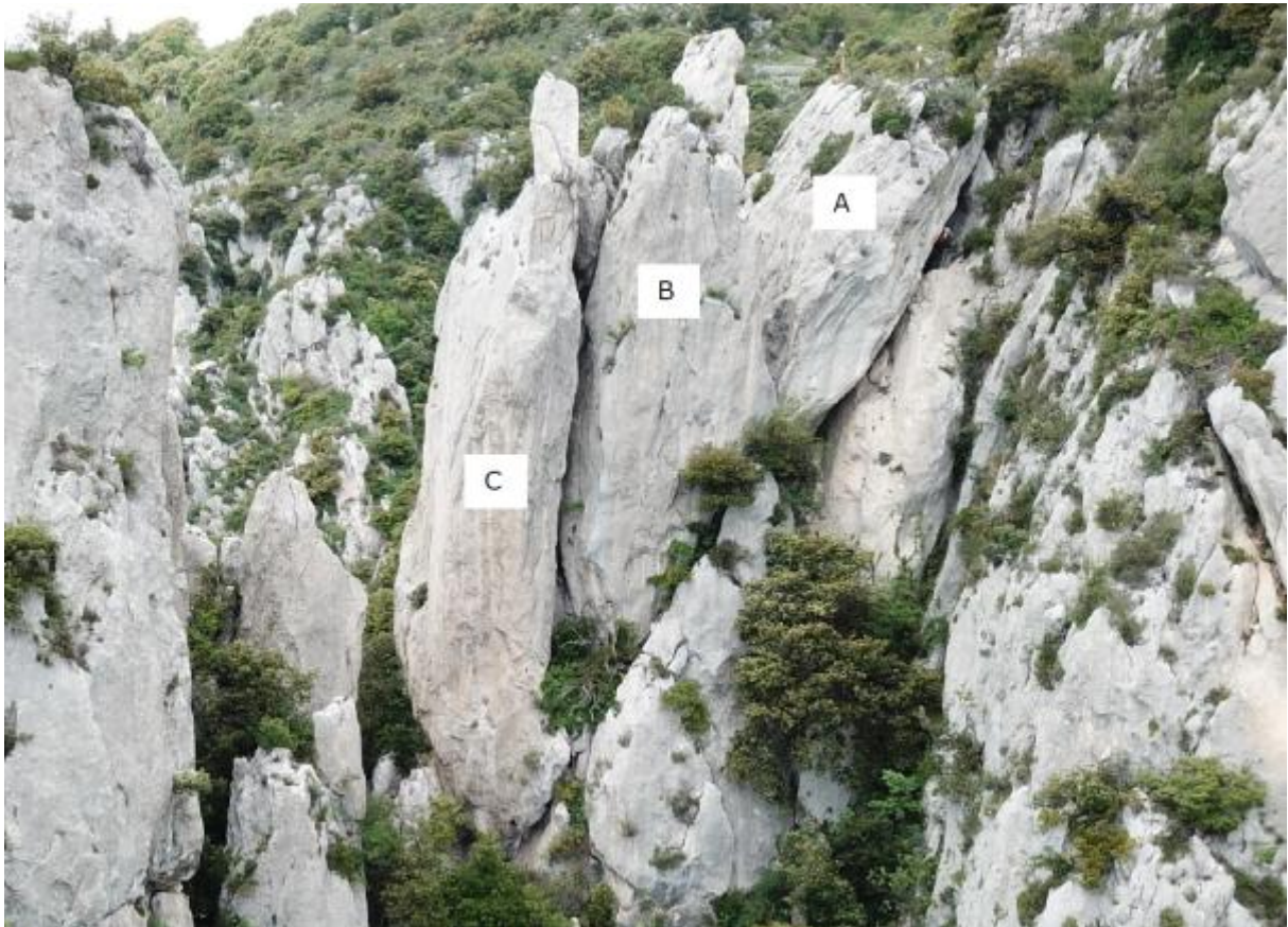
Figure 3 : Masses devant faire l'objet d'une purge par minage (côté est).
