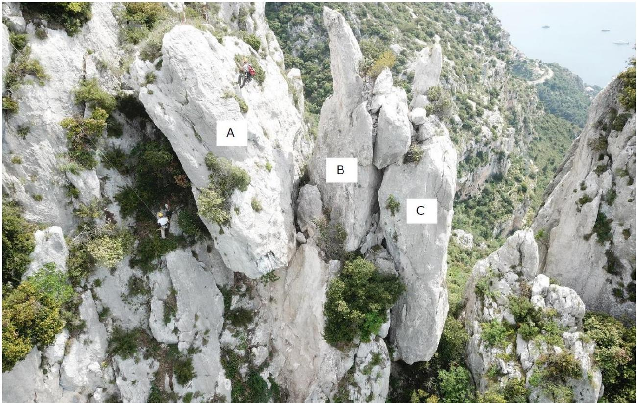
*Masses A, B & C devant faire l'objet d'une purge par minage (côté Ouest)*
