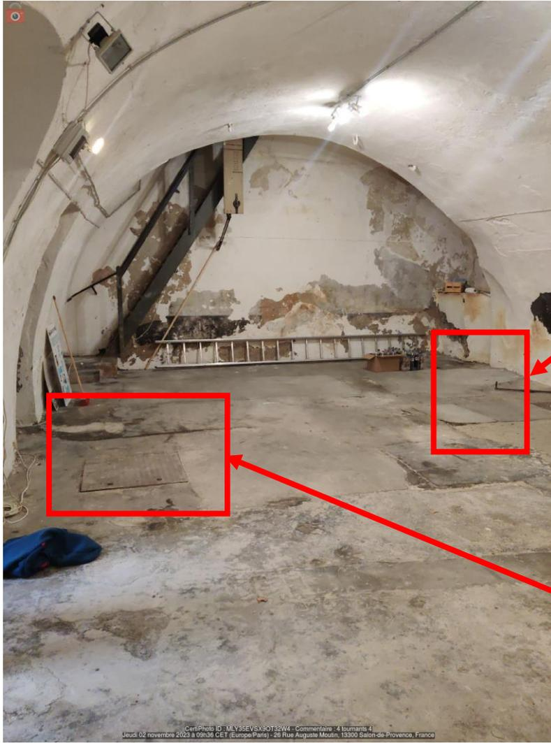
Photo 4 : Sous-sol du moulin avec regards conduite et canal sous-terrain (exutoire)
