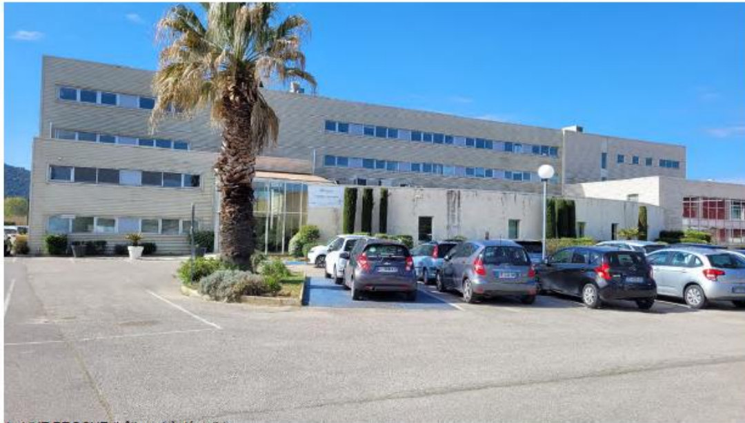
1 - VUE PROCHE (bâtiment à démolir)
