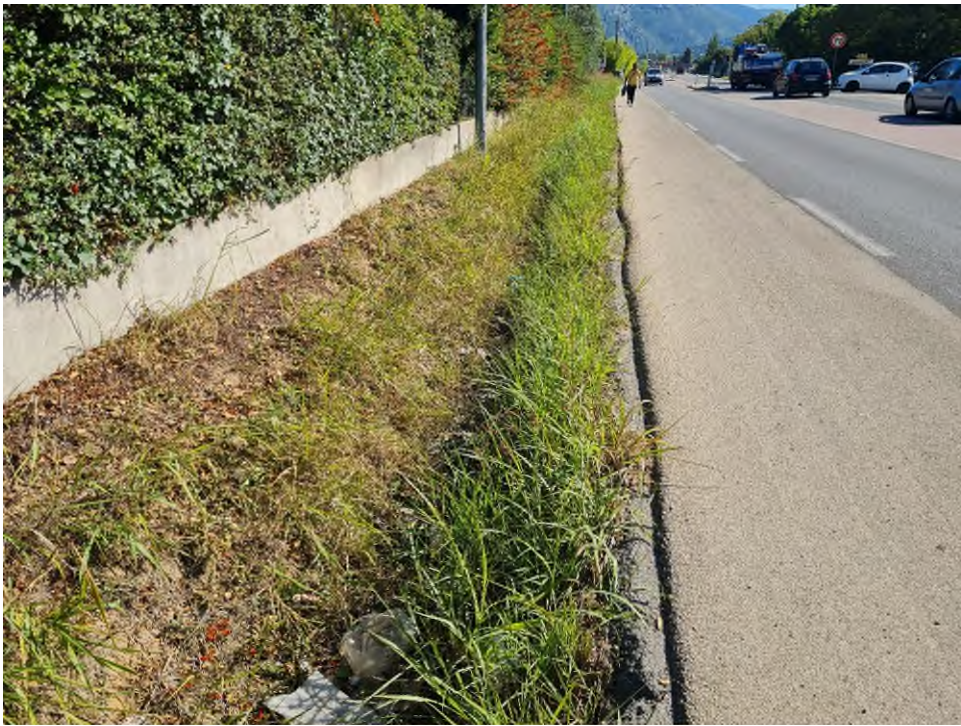
Figure 1 : Fossé permettant l'exondement de la route de Gémenos et de l'opération
