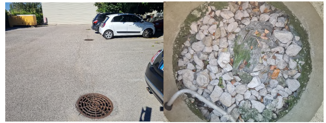
Figure 5 : Grilles situées sur la partie Sud du parking (à gauche) et vue à l'intérieur d'un regard comblé (à droite)
