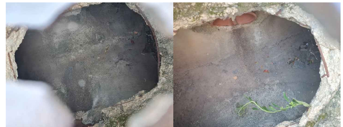
Figure 6 : Canalisations en D900 mm (à gauche) et D1000 mm (à droite) passant sous le parking de l'opération
