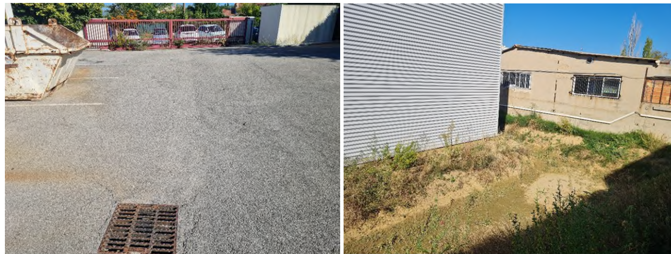
Figure 3 : Réseau récepteur sur le parking de l'opération et bâtiment en limite Ouest de l'opération bordé par un fossé
