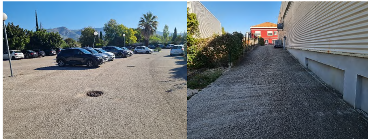
Figure 4 : Parking à l'entrée du site (à gauche) et rampe d'accès vers la zone basse (à droite)
