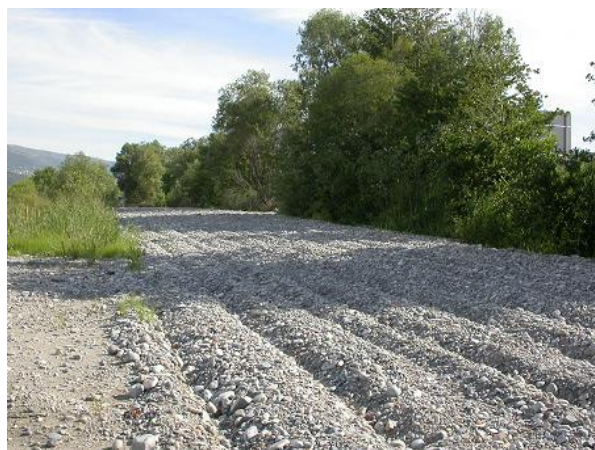
Berge de galet « ratissée » à la griffe (rive gauche)
