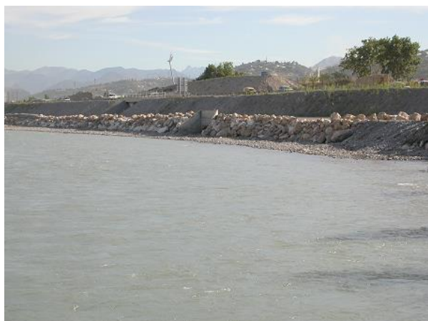
Enrochements en rive gauche
