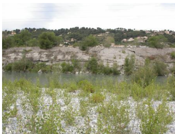
Talus artificiel faiblement végétalisé (rive droite)
