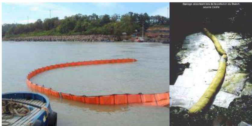
Figure 8 : Installation d'un barrage flottant (<http://www.flexitankchina.fr>) / Barrage absorbant ([cedre.fr](http://cedre.fr))
