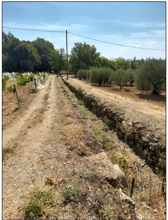
Photographie 8 : Ouvrage aval n°7 fossé en pierre maçonné Dimensions estimées : 1,50 m * 0,80 m (base x hauteur)
