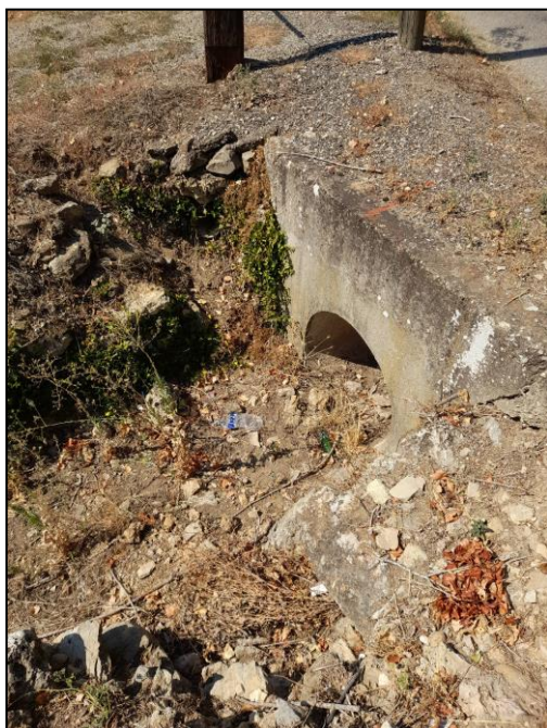
Photographies 5 et 6 : Evacuation de la buse n°6 et ouvrages n° n°7
