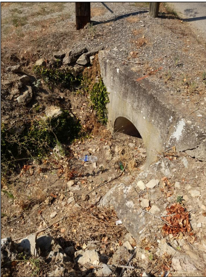
Photographie 7 : Canalisation Ø 800 mm en provenance du terrain du projet en aval du chemin de la Fenouillette Ouvrage N°6 en aval du terrain du projet
