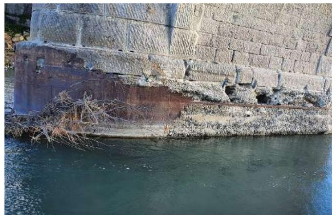
Vue P1 et protection appui dégradée / Béton érodé (12/2022)
