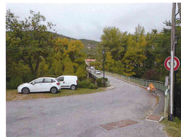
Photo 3 – Dessus d'ouvrage depuis la berge gauche (2023)
