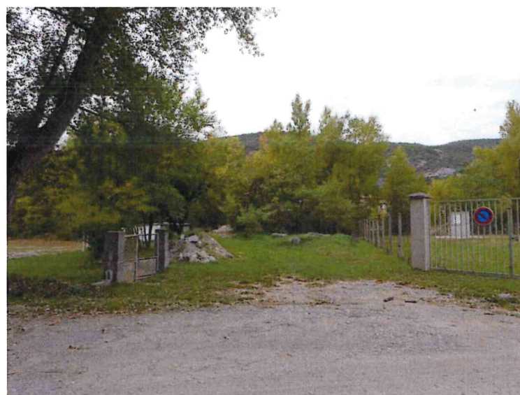
Photo 1 – Départ déviation en berge gauche (2023)
