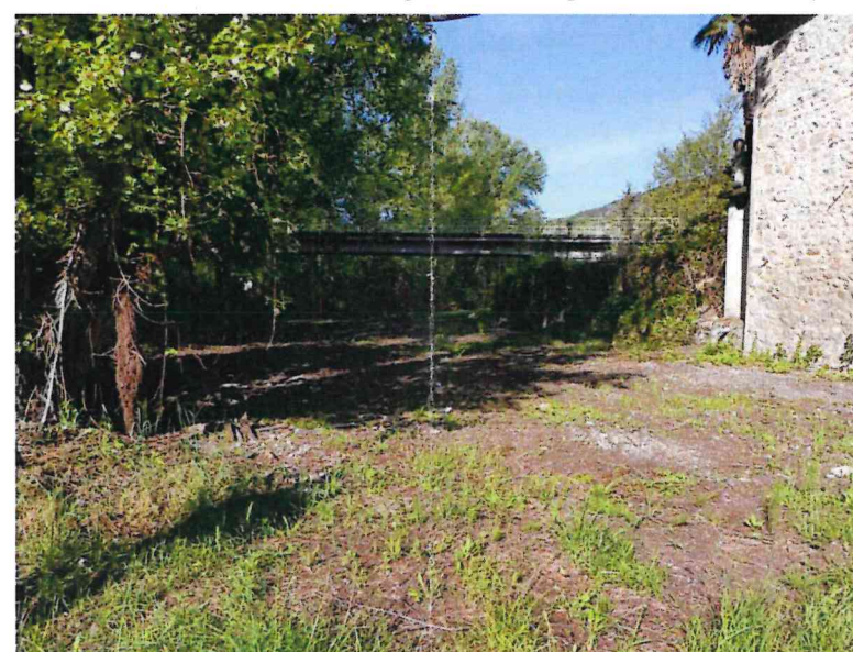
Photo 8 – Vue amont de l'ouvrage – travée droite (2023)
