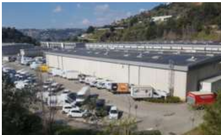
Hangars défavorables au gîte des chiroptères, 20/03/2023, M. PAJKOVIC
