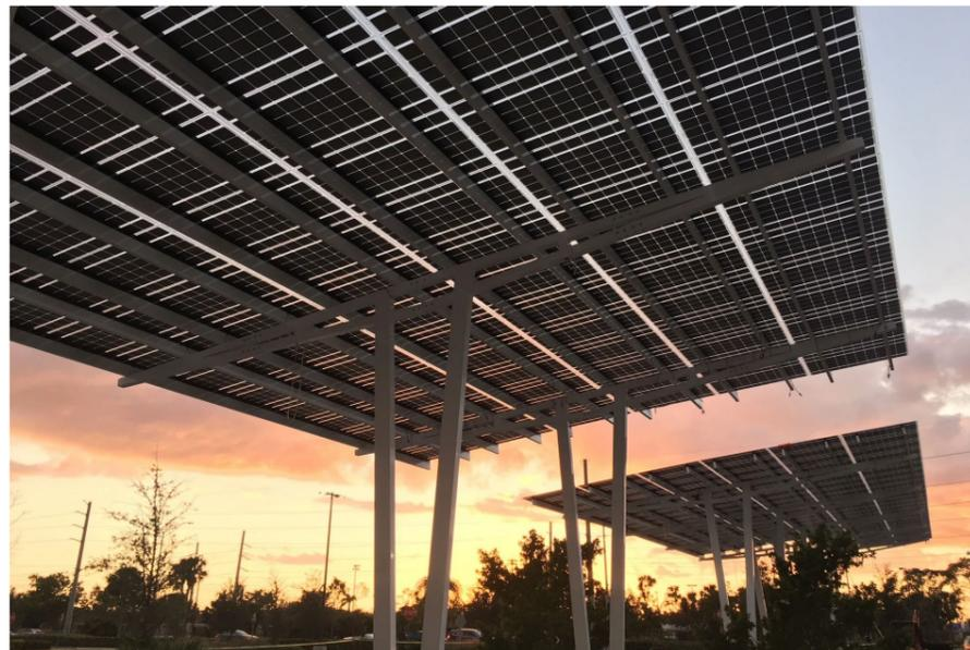
Figure 3 : Exemple de panneaux bifaciaux
